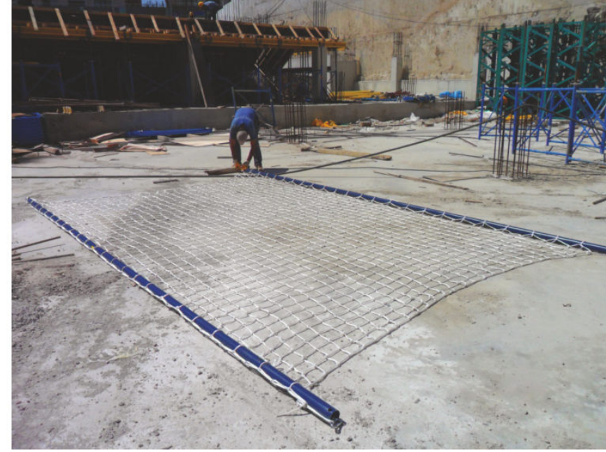
Safetynet Malzeme Örtüsü 2mm 20*20 Net 2mm 20*20
