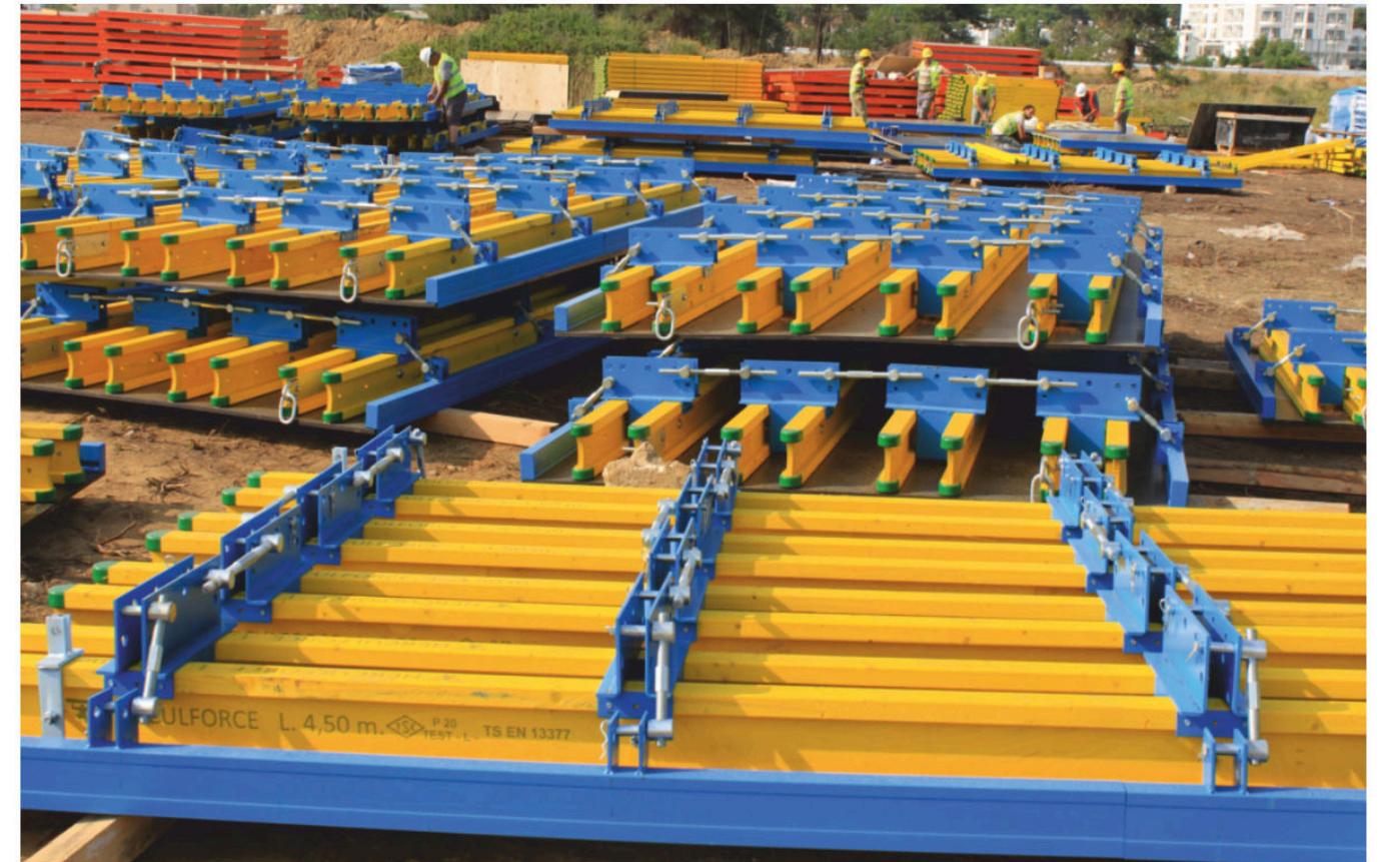
Adım 3 - Projeye göre şablon ile eğriliğin verilmesi Step 3 - Forming the curve according to the formwork design
